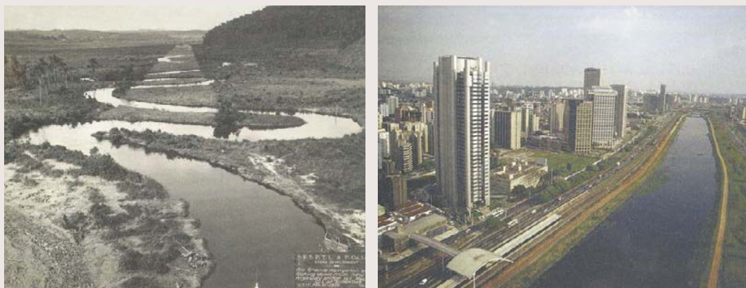
Figura 5 Transformação da calha do Rio Pinheiros, São Paulo, SP.
